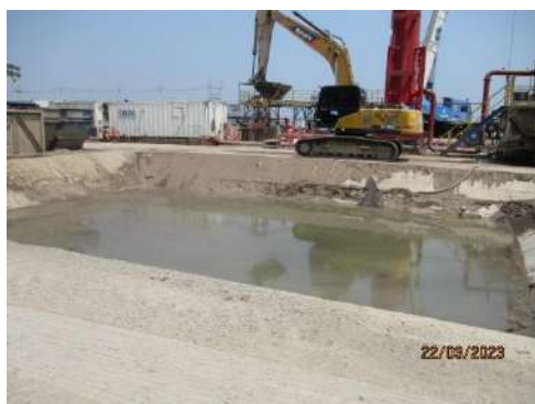
รูปที่ 2-14 บ่อคอนกรีตเก็บน้ำ (Concrete Liner Pit)
