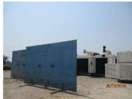
รูปที่ 2-4 กำแพงกันเสียงแบบแผ่นเหล็ก (Steel) ชั้นเดียว
