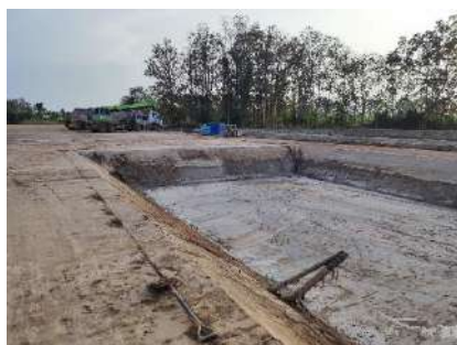
รูปที่ 2-18 ทำความสะอาดบ่อคอนกรีตเก็บน้ำ
