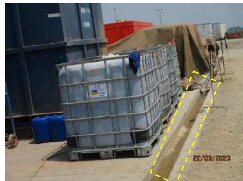
รูปที่ 2-30 รางระบายคอนกรีตล้อมรอบถังกักเก็บสารเคมี
